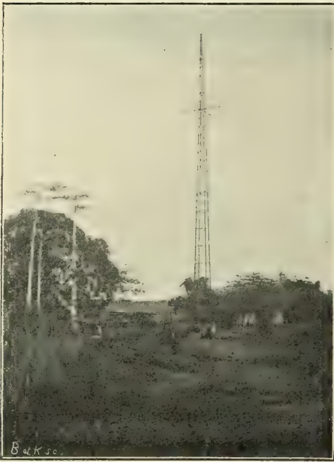
Fig. 69 — Support en fer de 56 mètres.
